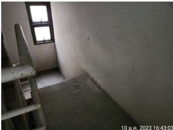
ภาพที่ 2-25 ผนังด้านที่บันไดหนีไฟขาดผ่านเป็นผนังกันไฟ
