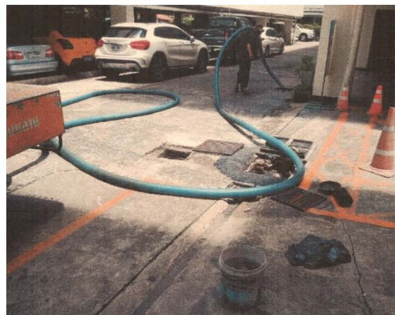
ภาพที่ 2-26 การกำจัดกากตะกอนออกจากระบบบำบัดน้ำเสีย
