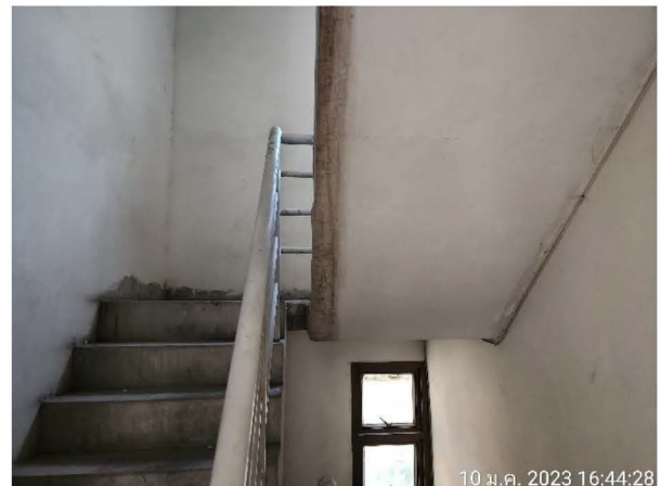
ภาพที่ 2-25 ผนังด้านที่บันไดหนีไฟขาดผ่านเป็นผนังกันไฟ
